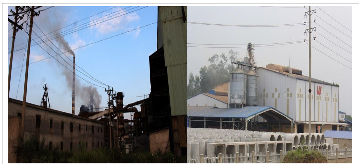
Hình 2.18. Hệ thống xả khí thải của Nhà máy luyện thép Toàn Thắng - KCN Sông Công và Nhà máy chế biến gỗ Công ty TNHH UJU VINA Thái Nguyên
