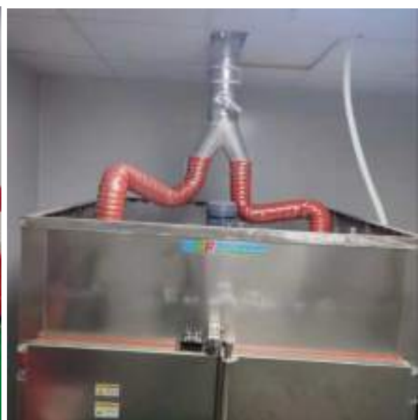
Hệ thống thu gom khí thải dây chuyền ép sấy
