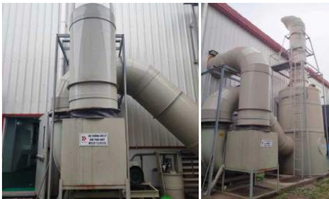
Hình 11. Hệ thống xử lý khí thải axit
