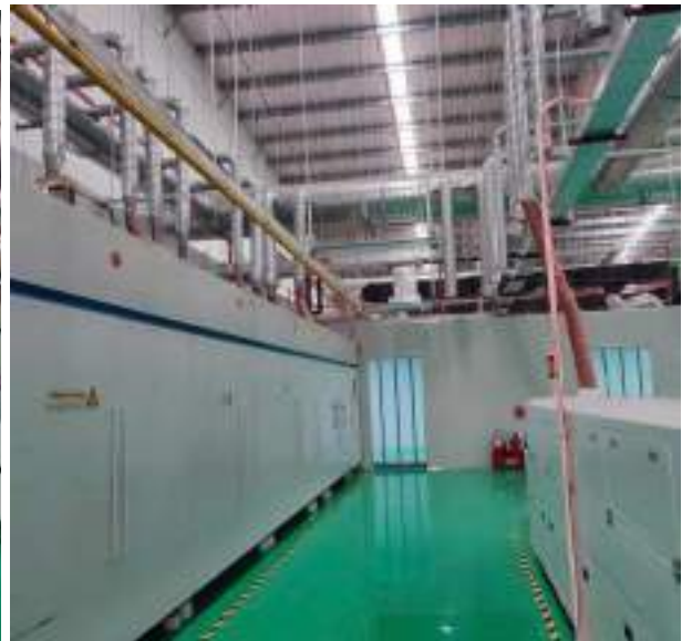
Hệ thống thu gom khí thải khu vực sấy nhiệt
